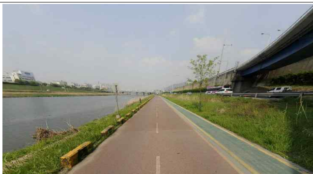
자전거도로 안전펜스 설치
