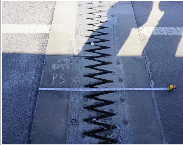
신축이음장치 유간 측정
