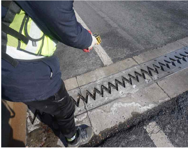
신축이음장치 온도 측정
