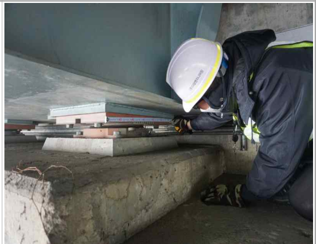
교량받침 이동량 측정
