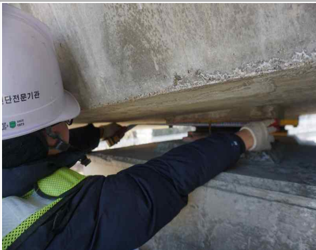
교량받침 이동량 측정
