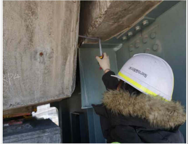
신축이음장치 유간 측정
