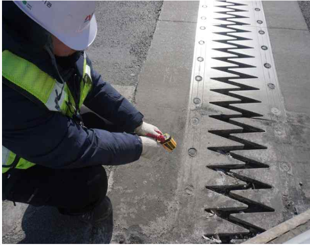
신축이음장치 온도 측정
