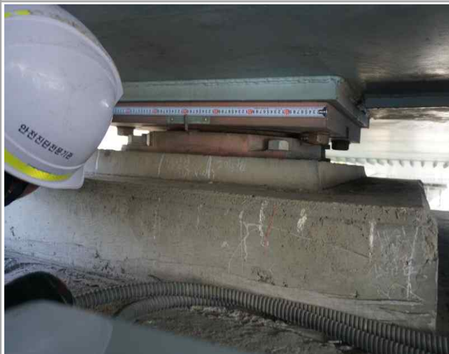
교량받침 이동량 측정
