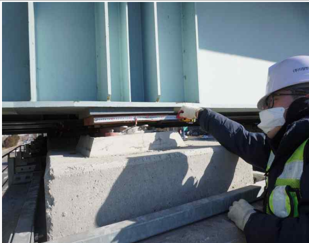
교량받침 이동량 측정
