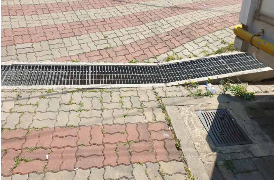
내용 : 공사 전
