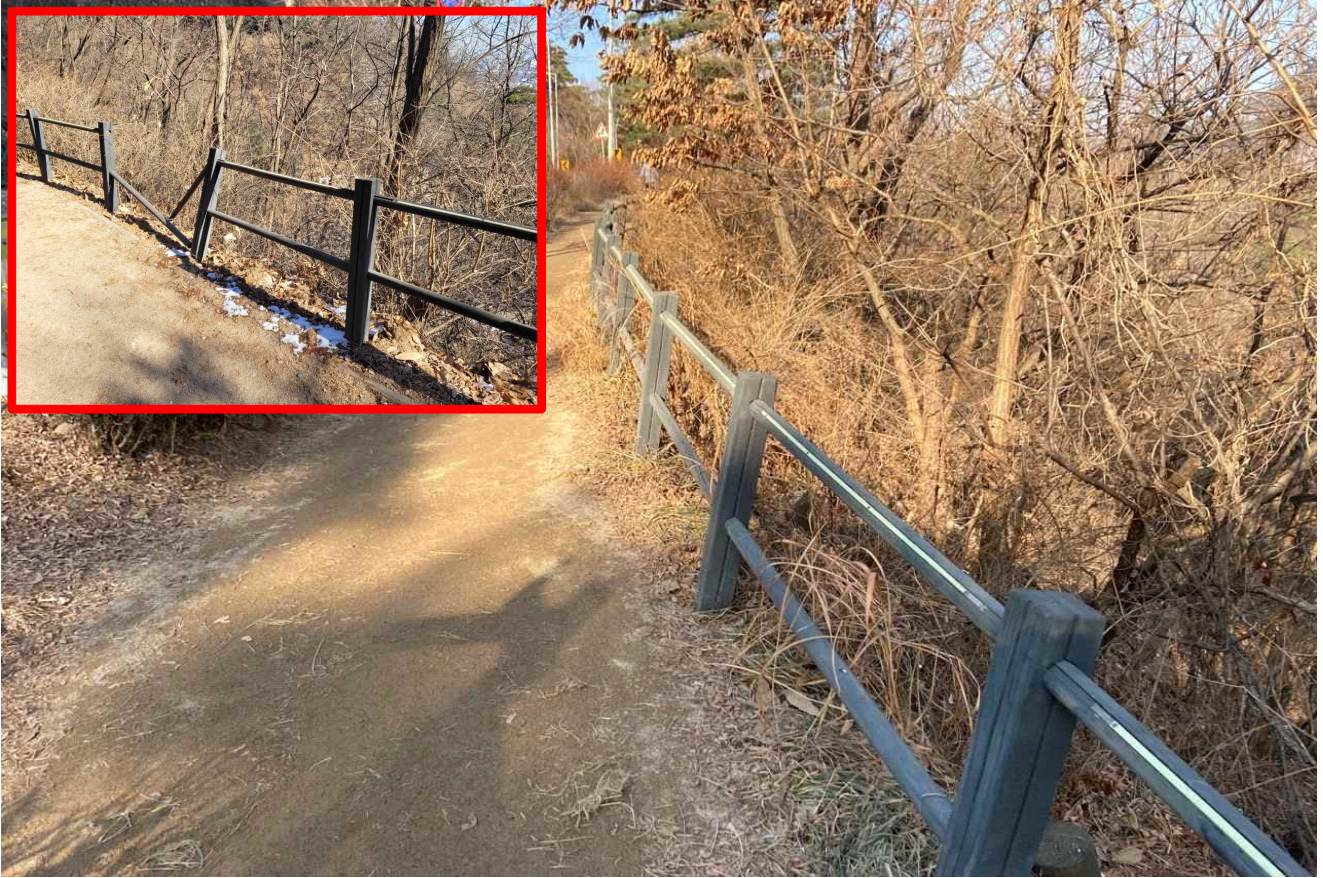
안전난간 및 바닥 정비 전
