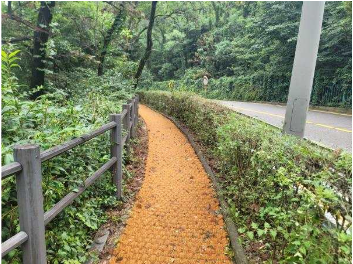
야자매트 설치 후
