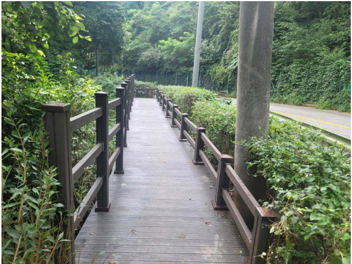
데크로드 및 안전난간 공사 후
