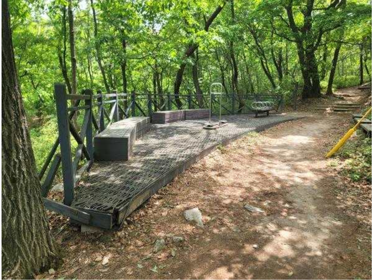
휴게데크 공사 전
