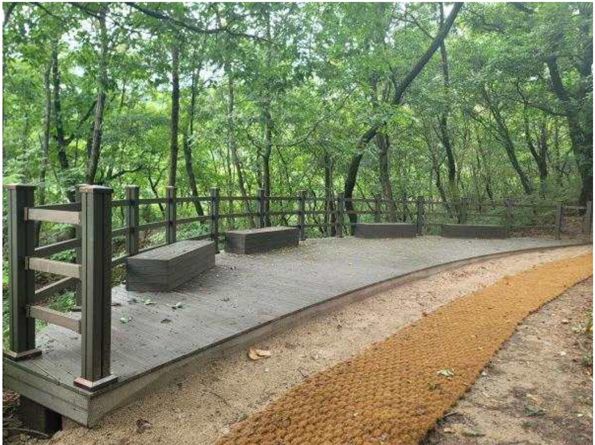
휴게데크 공사 후
