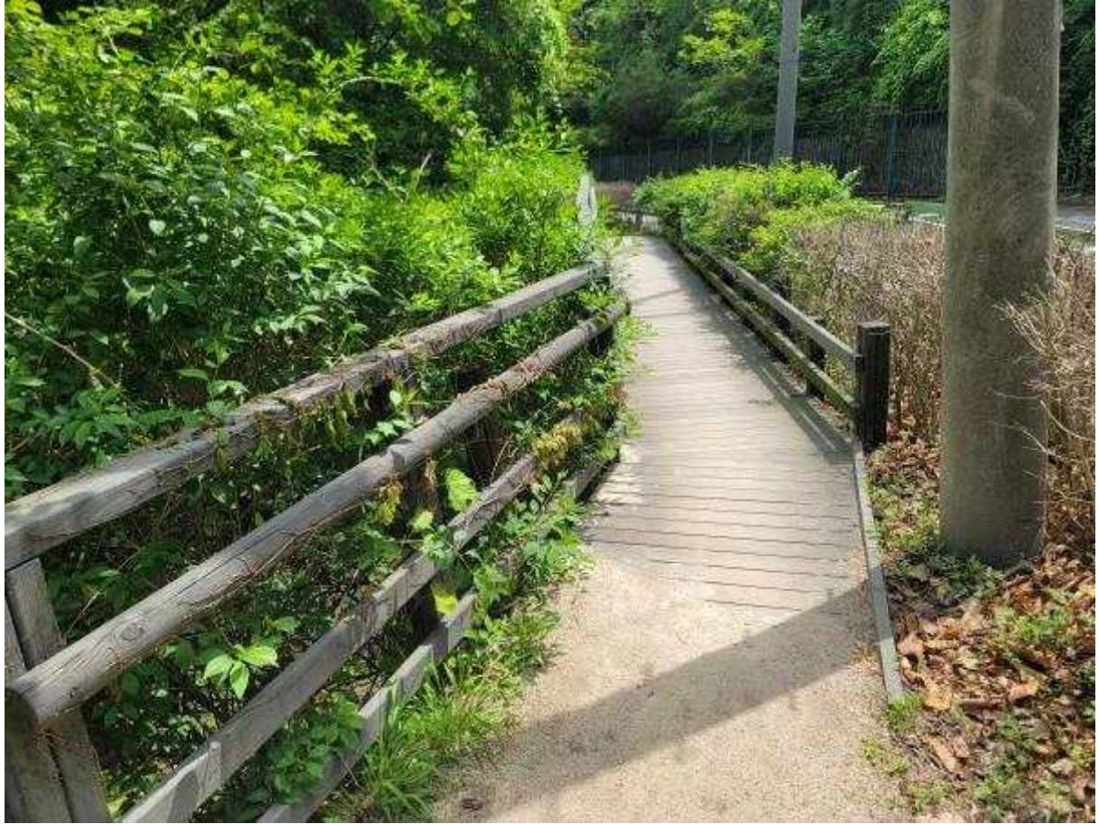
데크로드 및 안전난간 공사 전
