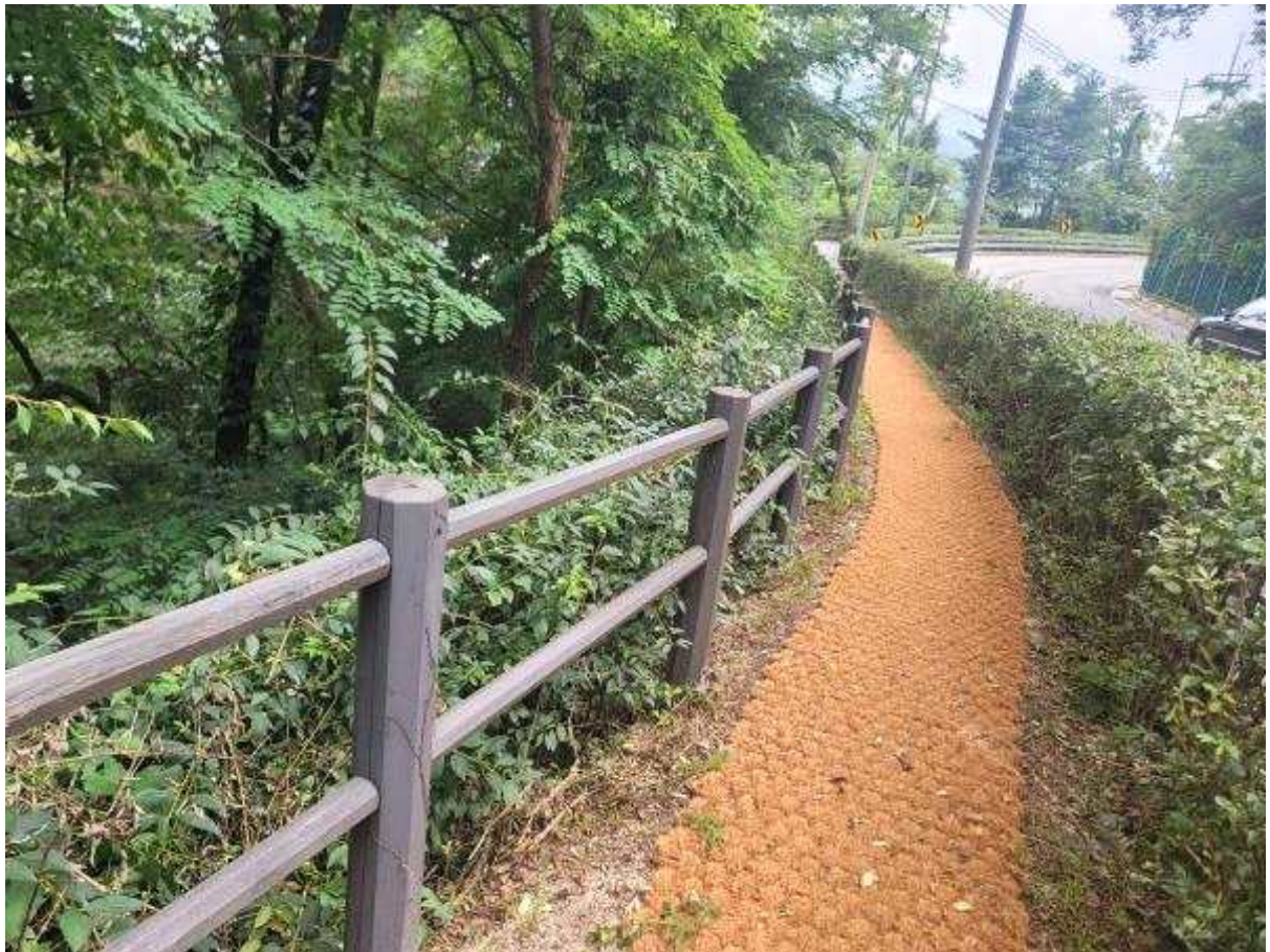
안전난간 보수 후
