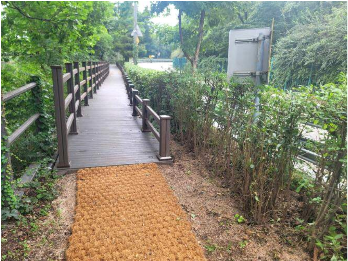
데크로드 및 안전난간 공사 후
