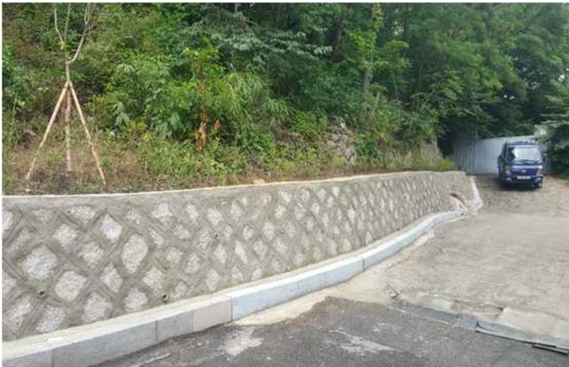
(사면정리 후 석축쌓기 및 수목식재)
