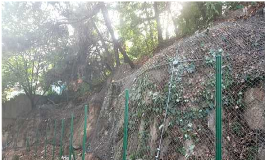
(암반사면정리 후 낙석방지망 설치)
