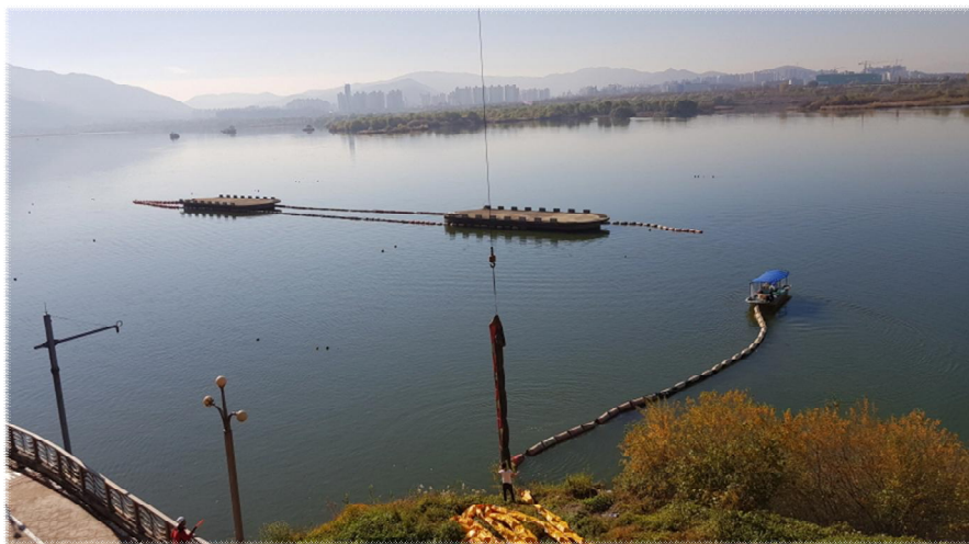
위치 강북취수장 취수구 설명 조류차단막·오일웬스 설치 중
