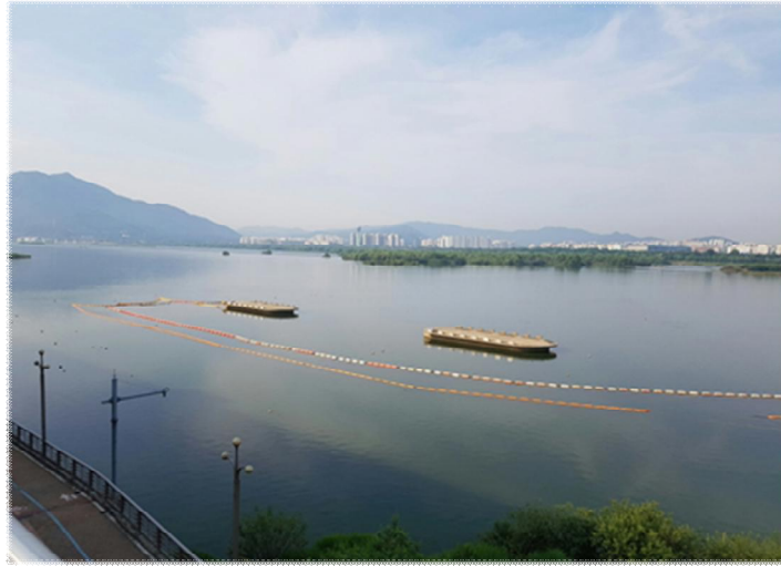
위치 | 강북취수장 취수구 | 설명 | 조류차단막·오일웬스 철거 중
