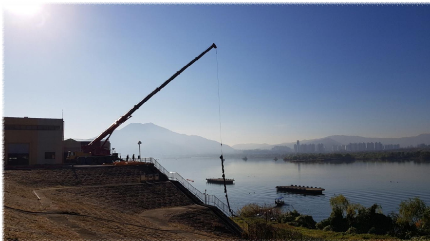
위치 강북취수장 취수구 설명 조류차단막·오일웬스 설치 중
