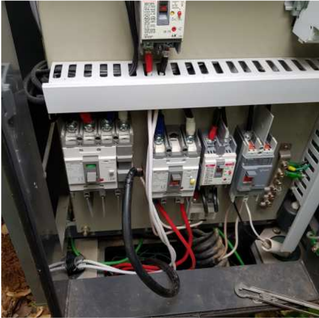
재배온실 메인차단기 설치 및 간선 포설전 사진
