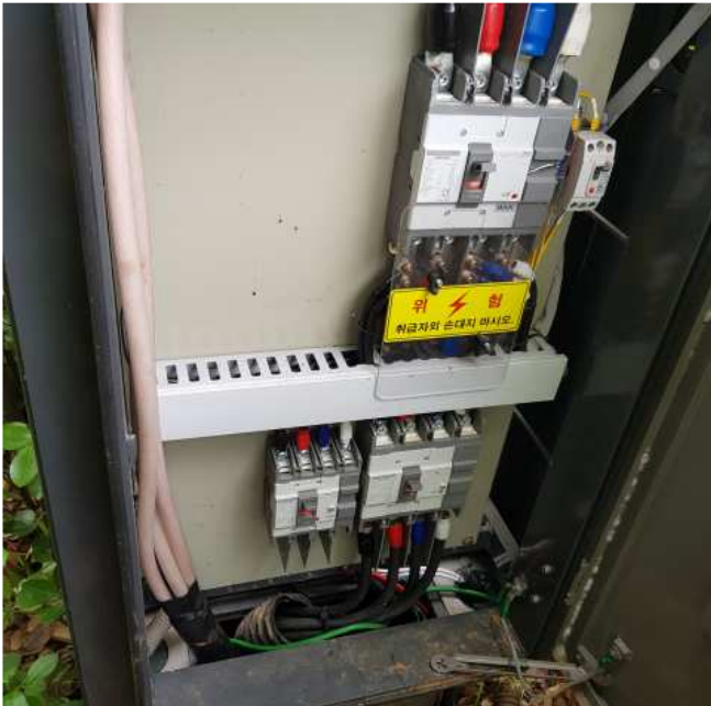
대기실 메인차단기 설치 및 간선 포설전 사진
