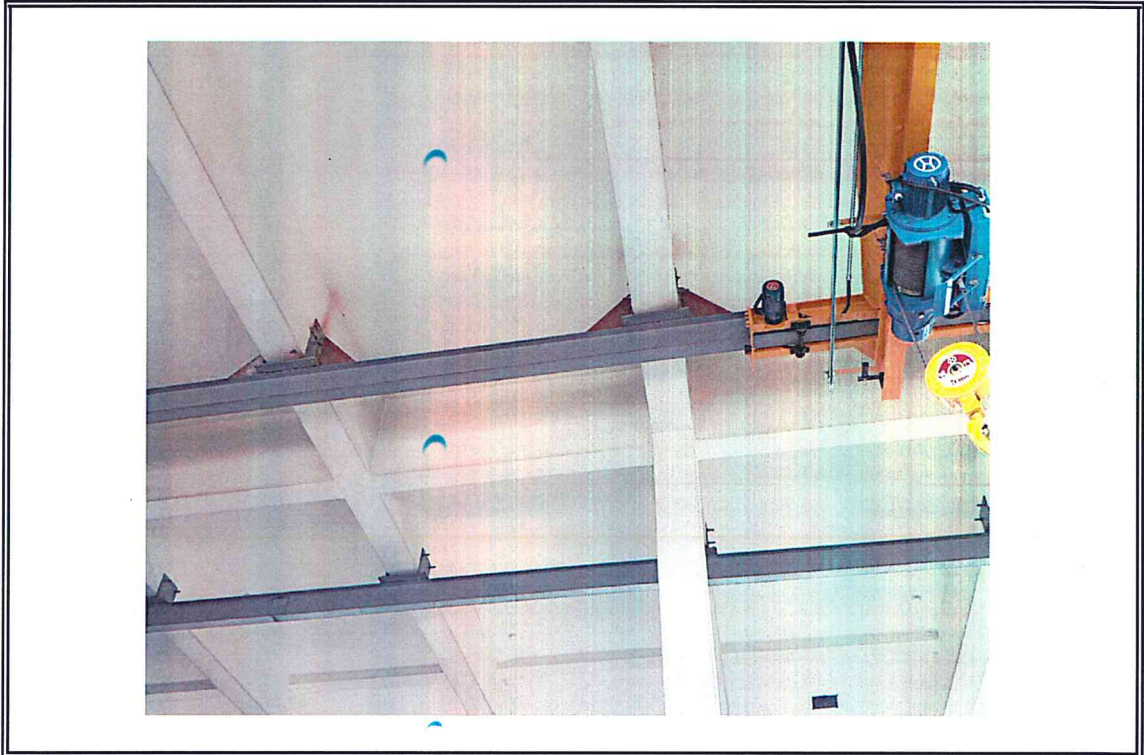
내 용 신규 크레인 설치 전경
