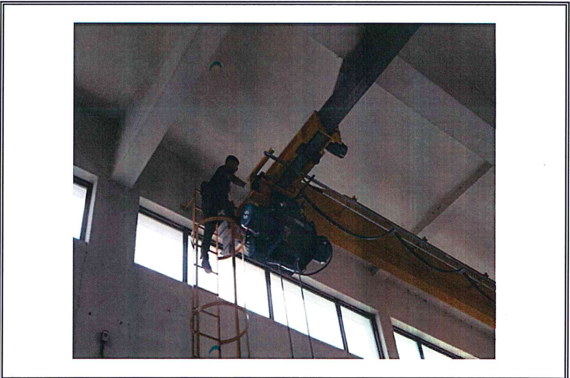
내 용 신규 크레인 설치 전경
