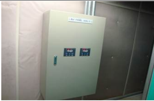
공조기 인버터 설치 공사
