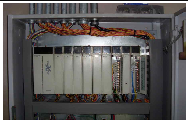
자동제어 DDC 결선 공사
