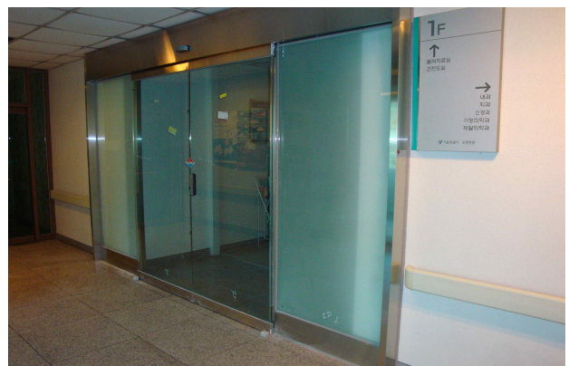
자동문 설치 (물리치료실)
