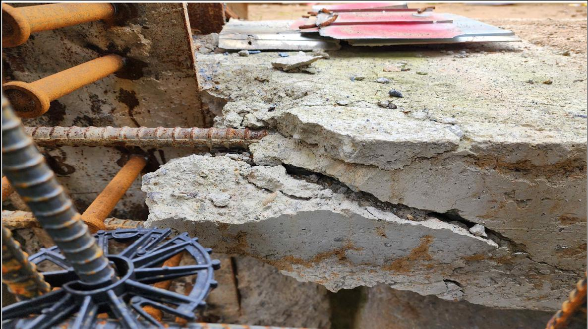
지적사항 : 지하 합벽 CIP Cap Beam 깨진 부분 제거 후 콘크리트 타설하기 바람
