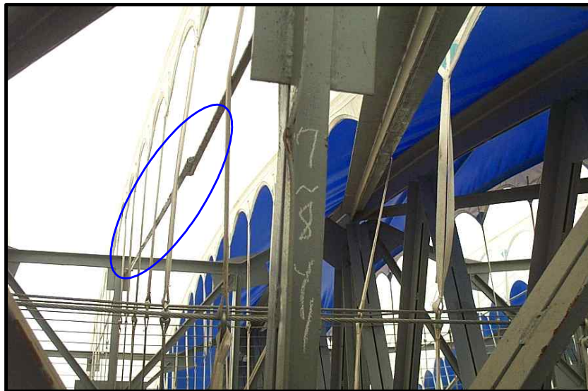
<TIE ROD 설치사진>
