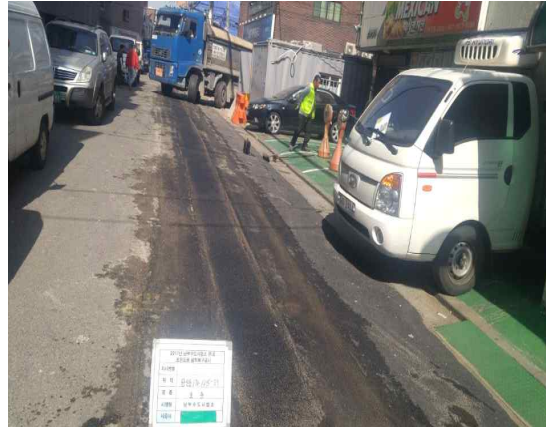
공종 : 보수 완료
