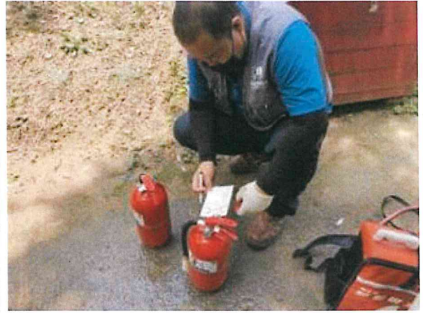
유아숲체험원 내 소화기 상태 점검
