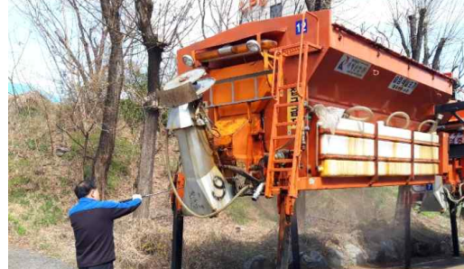
오염물 제거 고압수 세척 작업
