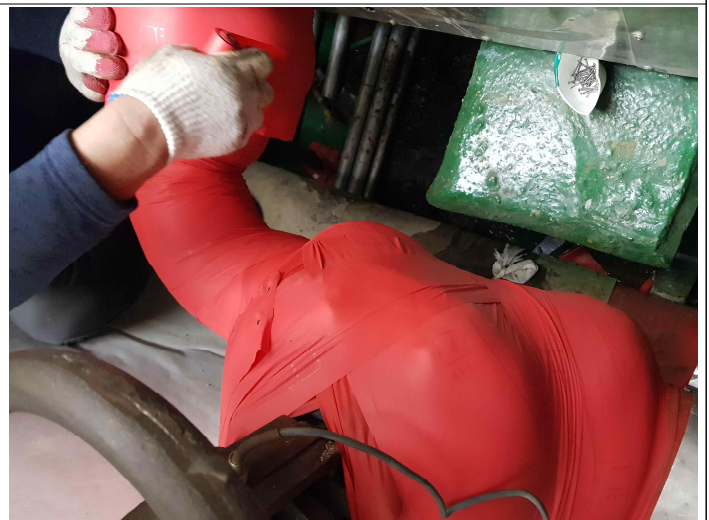
엘보관 설치 및 테이핑
