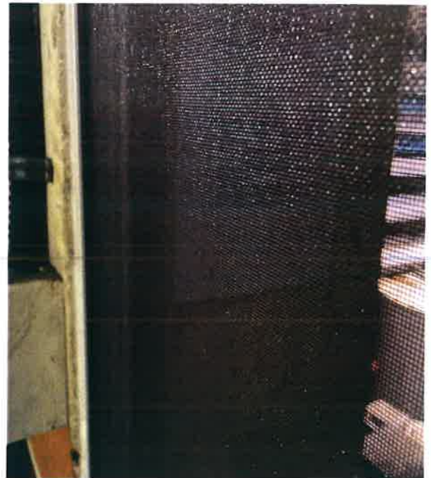
건물 내 방충망 손상 없음
