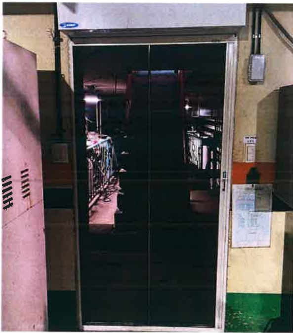
건물 내 출입구 등 방충망 설치
