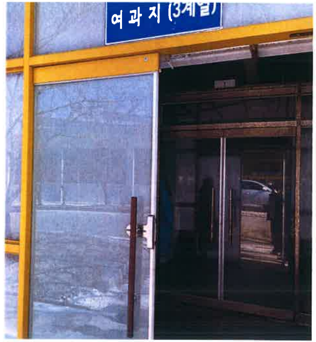
여과지 출입문 이중문 설치
