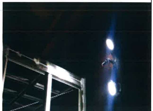
CCTV 및 조명 설치
