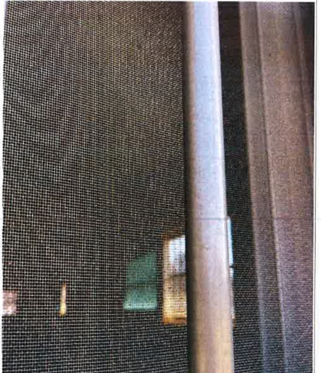
상부 환기구 방충망 손상 부분 없음
