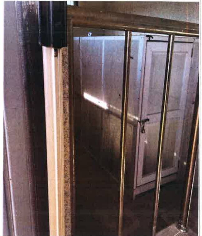
정수지 출입문(이중문) 잠금
