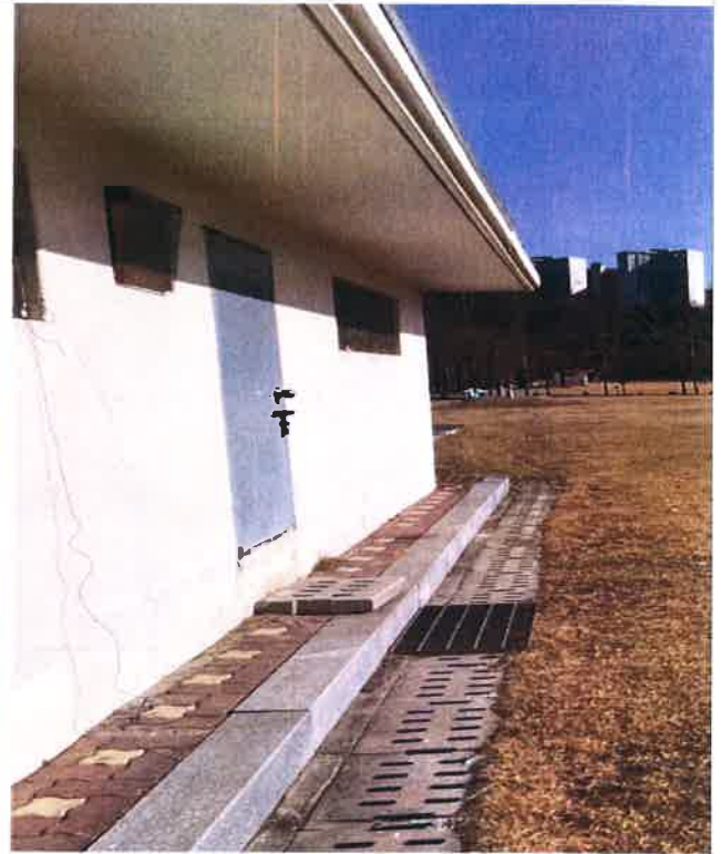
외벽 기준 반경 5m 내 물 웅덩이 없음
