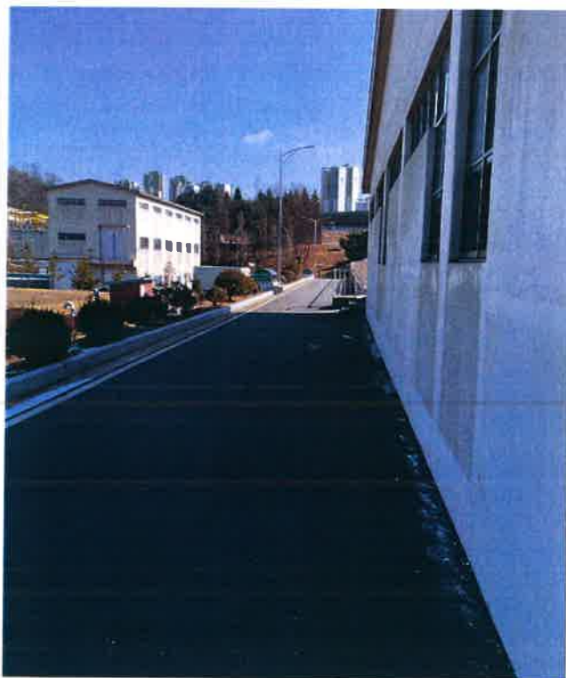
외벽 기준 반경 5m 내 물 웅덩이 없음
