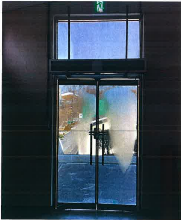
출입부 에어커튼 설치
