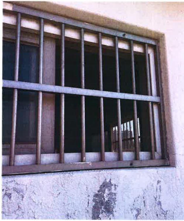
환풍구(환기구) 방충망 설치
