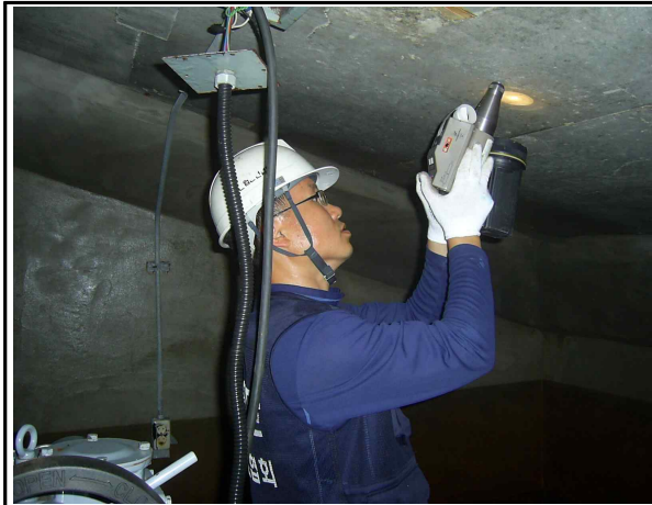
콘크리트 강도조사(유입구 상부슬래브)
