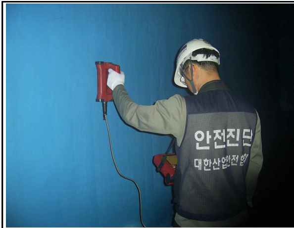
철근배근상태조사 (배수지 내측벽체)
