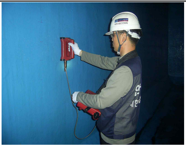
철근배근상태조사 (배수지 중간벽체)
