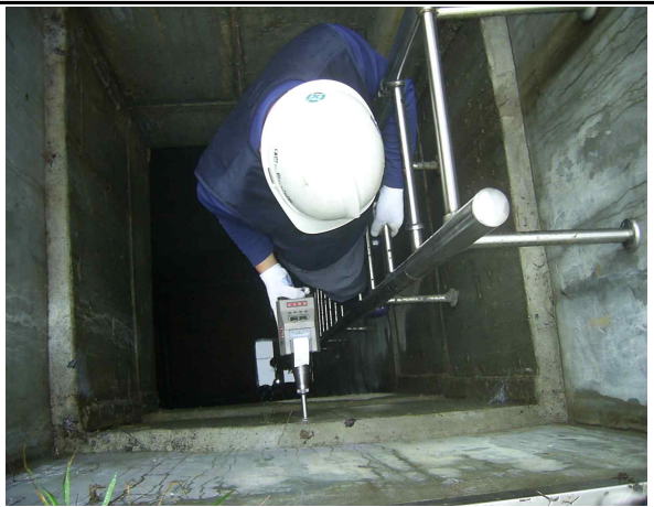
콘크리트 강도조사(유출구 벽체)
