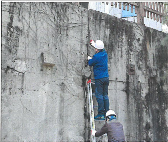
외부 옹벽 상태 점검
