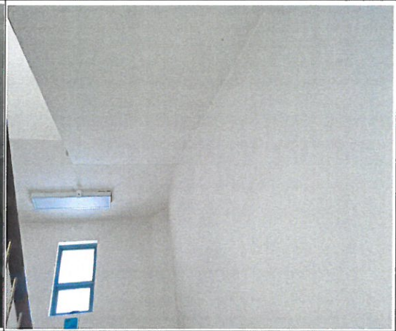
천장 보 변형 및 균열여부 점검
