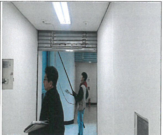
방화셔터 작동 점검
