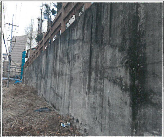
외부 옹벽 및 울타리 상태 점검
