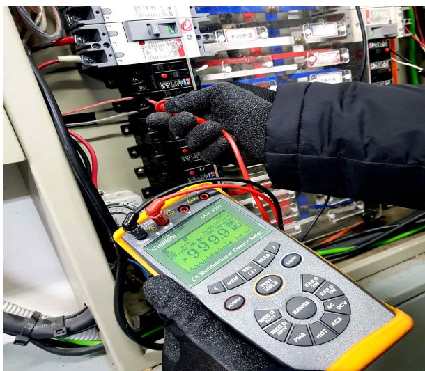
분전반 절연저항 측정
