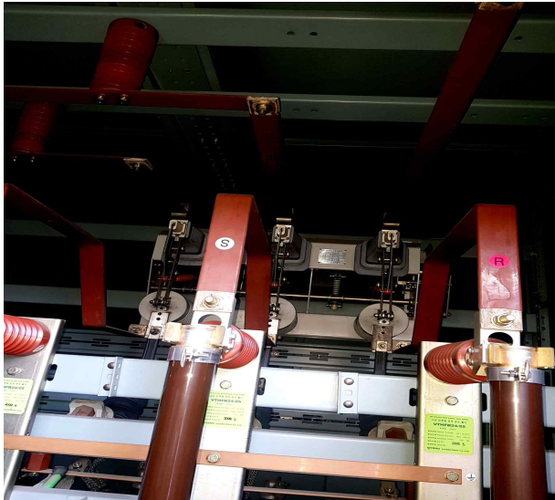
AISS KNIFE 접점 상태 확인
