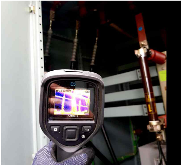
고압 및 저압기기 열화상 측정
