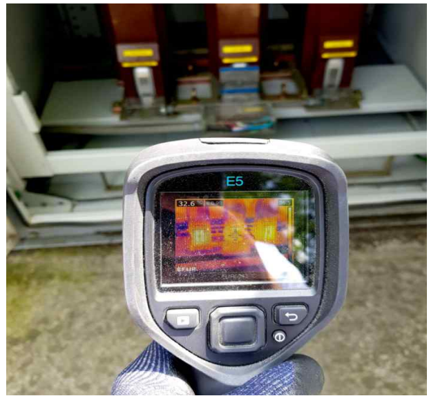
고압 및 저압기기 열화상 측정
