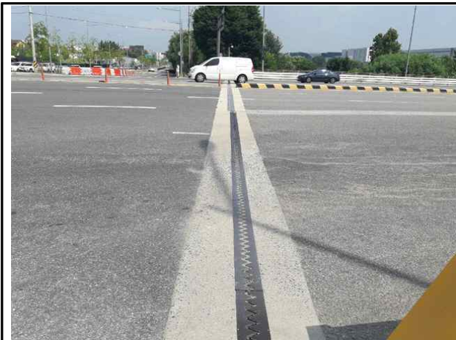
연번: 대곡교 신축이음장치(A1, 핑거조인트)
