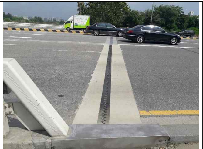
연번: 대곡교 신축이음장치(A2, 핑거조인트)
