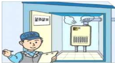
보일러실 배기통 점검
