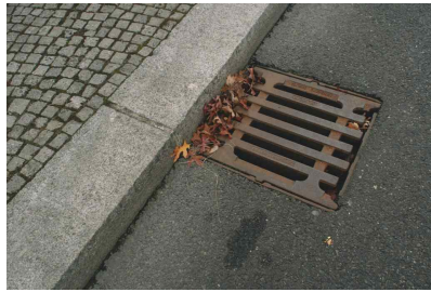
배수구, 하수관거 등 배수시설 점검
