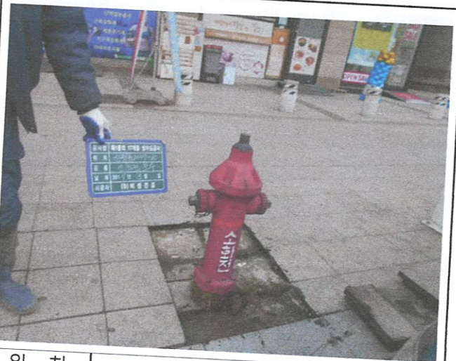
위치: 양천구 신정동 1007-10 공종: 지상식소화전 교체(전)
