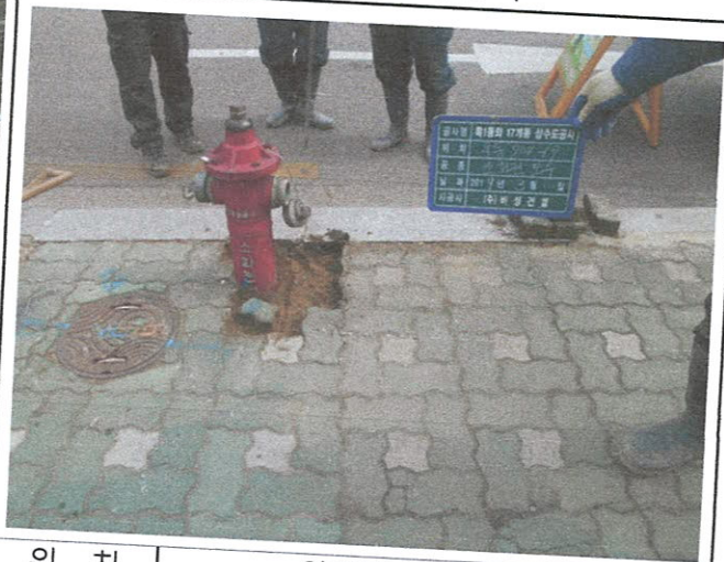
위치: 양천구 목동 904-19 공종: 지상식소화전 교체(전)
