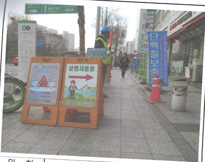
위치: 양천구 신정동 1007-10 공종: 시공 전
