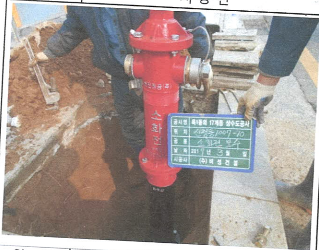
위치: 양천구 신정동 1007-10 공종: 지상식소화전 교체(후)
