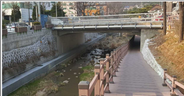
사례1) 하천내 산책로 설치
