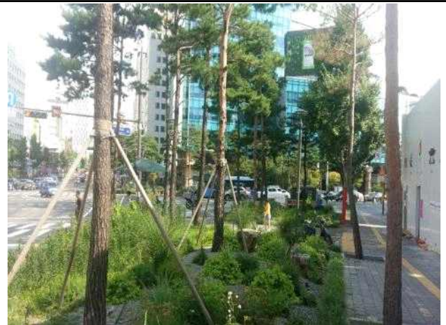
녹지대 수목 지지대 설치 후(중구)
