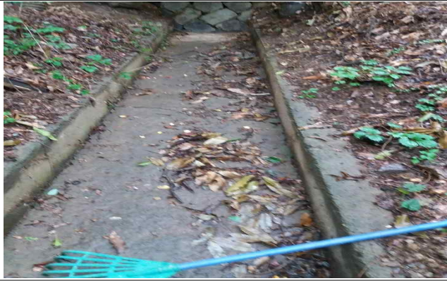
가로녹지대 배수로 청소 전(동작구)
