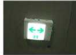
▲ 통로유도등이 올바르게 설치된 경우
