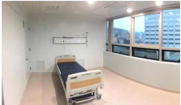
그림 21 배기구 설치 사례(병상 하부 배기)
