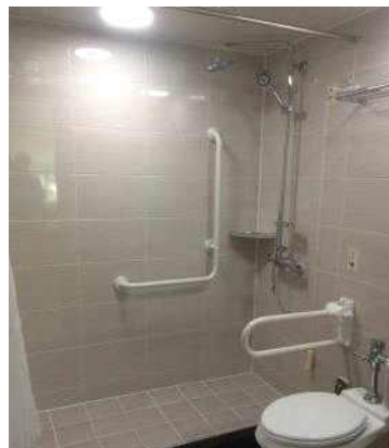
그림 28 화장실 내 샤워실 설치 사례
