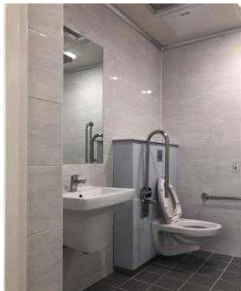
그림 27 벽부형 세면기 및 대변기 설치 사례
