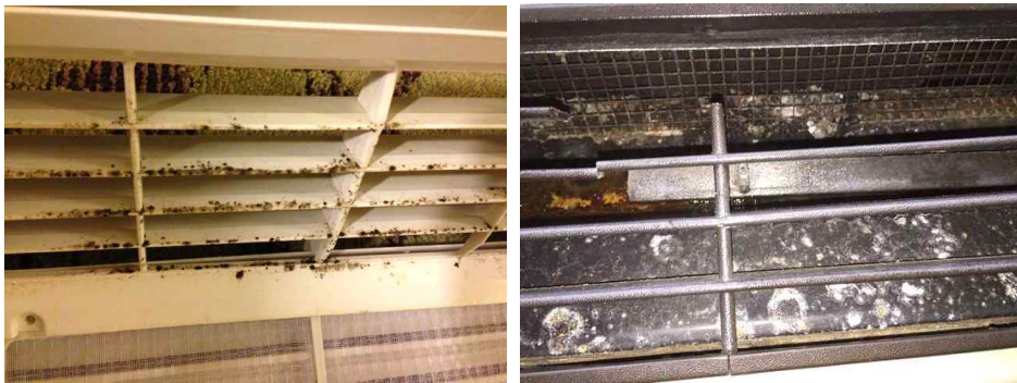
그림 75 재순환냉난방장치 내부의 곰팡이 오염
