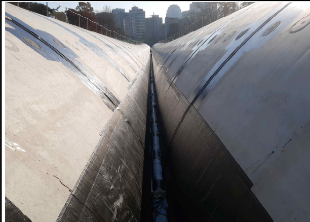
중앙부 하단 맹암거위치 방수재 설치광경
