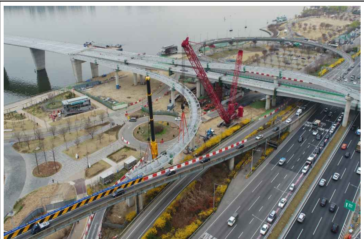
사진내용 북단 강변북로 시공전경
