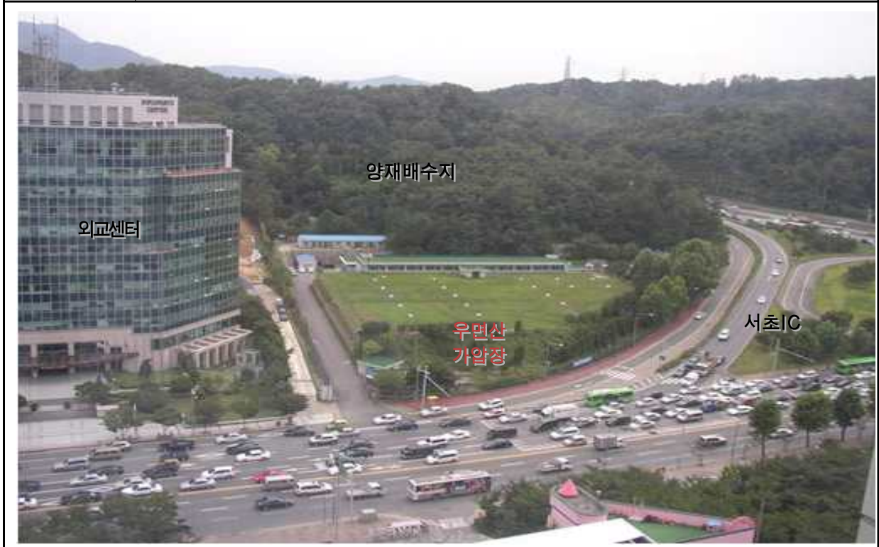
현장사진 우면산가압장 및 양재가압장 설치 예정지 전경
