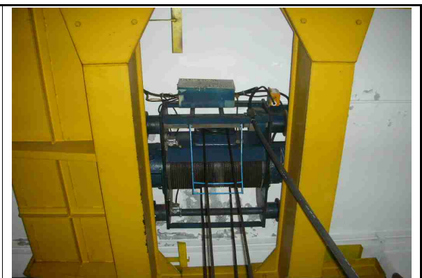
권양기 - 와이어로프 상태 양호
