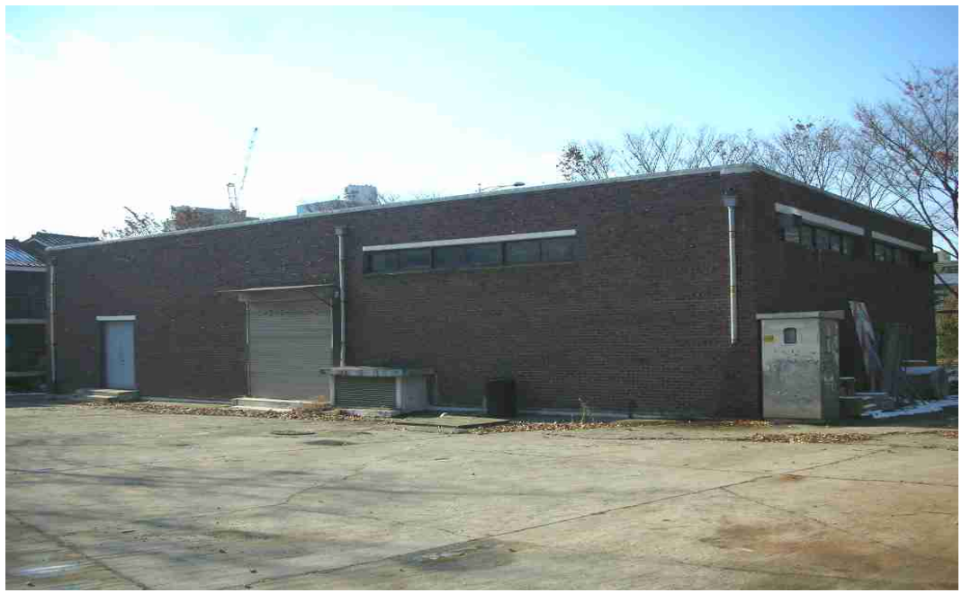
오금배수지 관리동 전경
