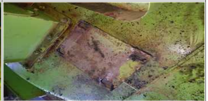
교반기 / 이송모터 BKT 용접수리 후
