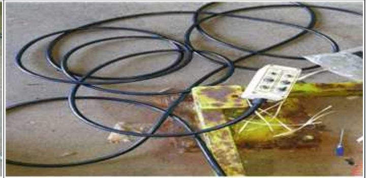
교반기 / 컨트롤배선 교환 후
