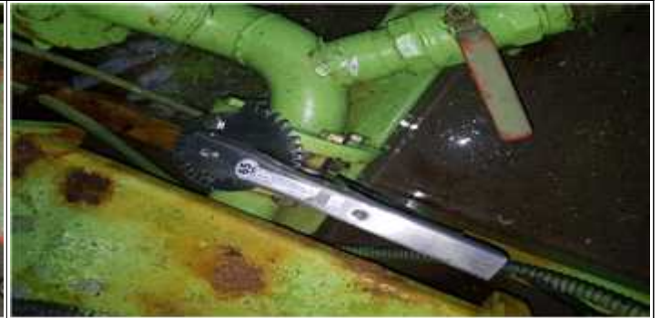
교반기 / 버터플라이밸브 교환 후
