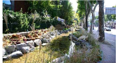
홍덕동천 물길 주변 수경시설, 식재 조성
