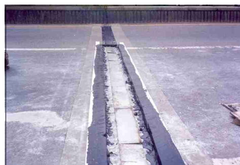
④ 도로봉합제 지지판 설치
