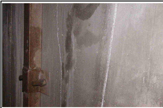
【사진 I.2.7】 교각 코핑부 균열
