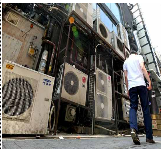
보행도로 옆 설치
