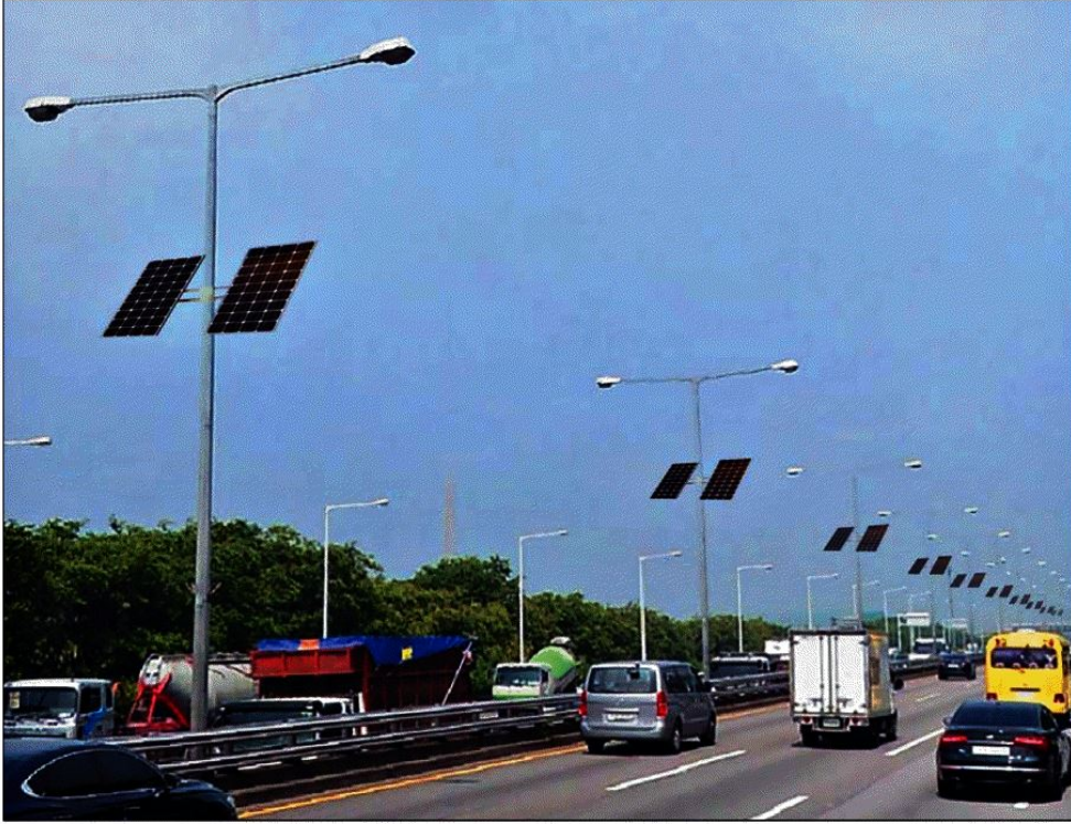
서울 마포구 하늘공원 앞 강변북로 가로등 기둥에 오는 6월까지 설치되는 태양광 패널 조감도. 강변북로에 설치된 가로등 기둥은 시내보다 더 높아서 태양광 패널을 설치하기에 유리하다고 시는 밝혔다. 서울시제공
