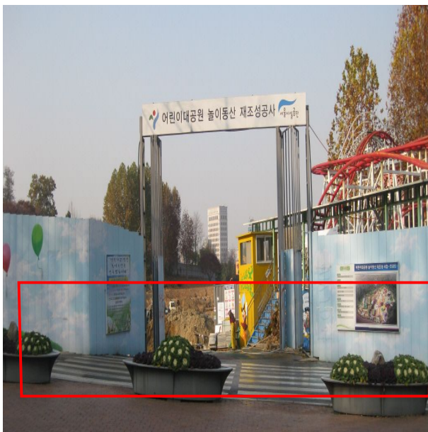
입구게이트 설치 대상지
