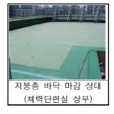
양천소방서 건축물의 강당 지붕층 바 닥은 시트방수 위 무근콘크리트(THK 70~THK170)가 시공되어 있으며. 체력 단련실 등의 지붕층 바닥은 무근콘크리 트(THK150) 위 우레탄방수가 시공되 어있다. 지붕층 바닥의 보 및 슬래브의 누수 현상을 조사한 결과 양호한 것으 로 조사되었으나. COOLING TOWER 기초 및 에어컨 실외기 기초, 연결 통 로 조성을 위한 파라펫 철거시 방수층
