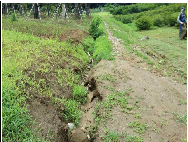
갈매양묘장 배수로 설치
