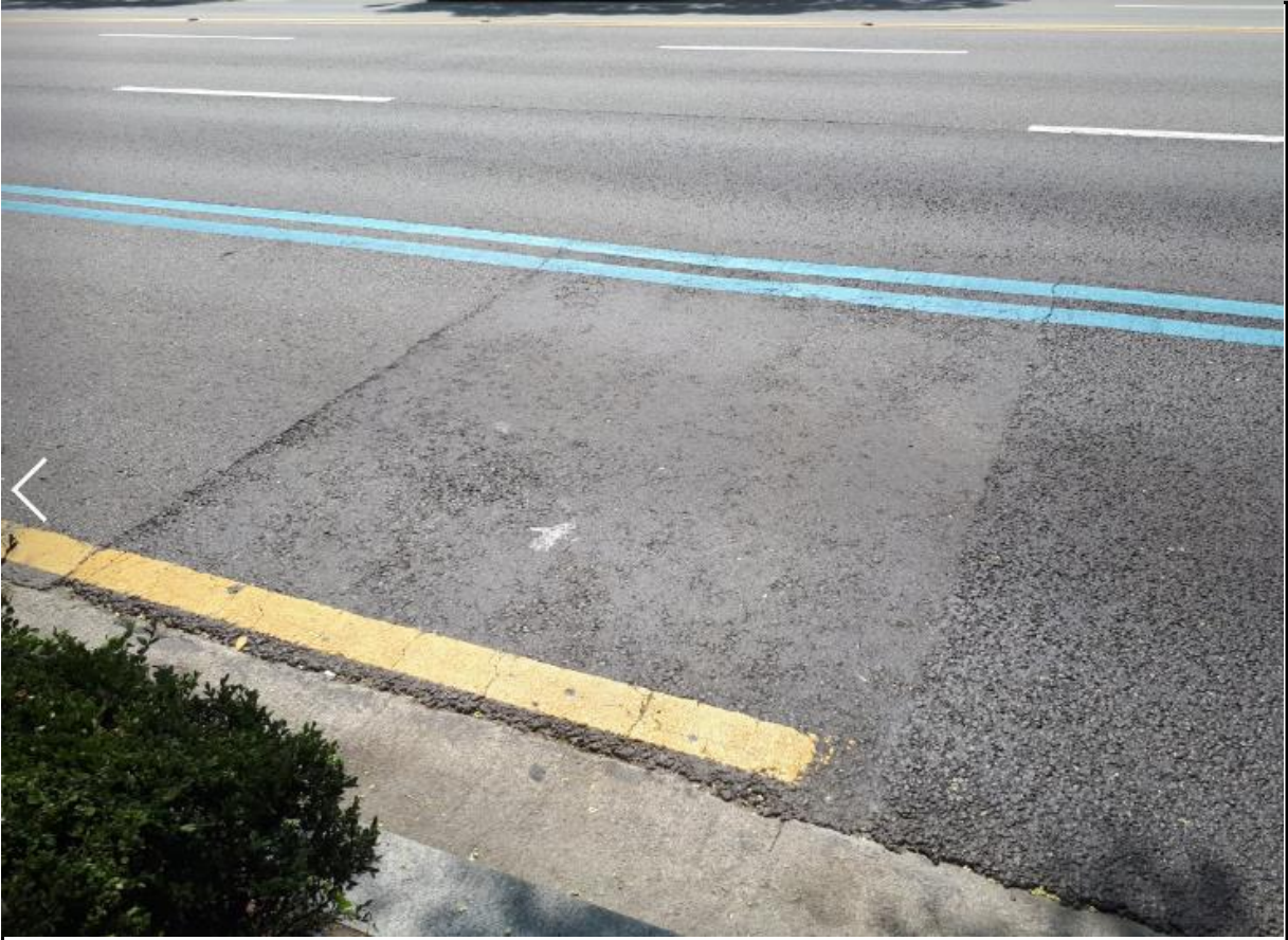
당초 정비용구간 종점부 포장현황
