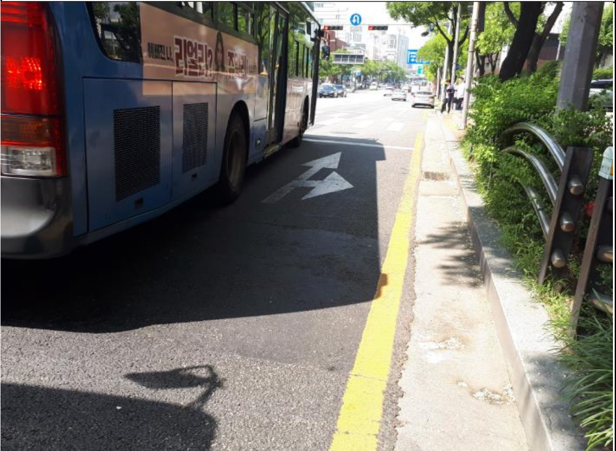
추가 정비용구간 시점부 포장상태
