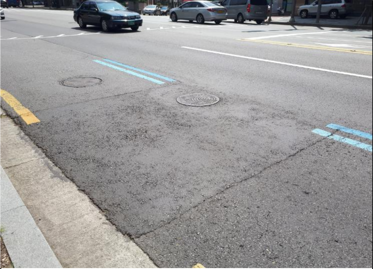
추가 정비요청 구간내 횡단굴착 현황
