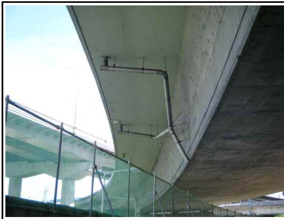
배수관 길이연장 현황(S1/도로횡단구간)
