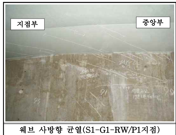
【사진 3.2】 P.S.C Box 내부의 손상현황(1)
