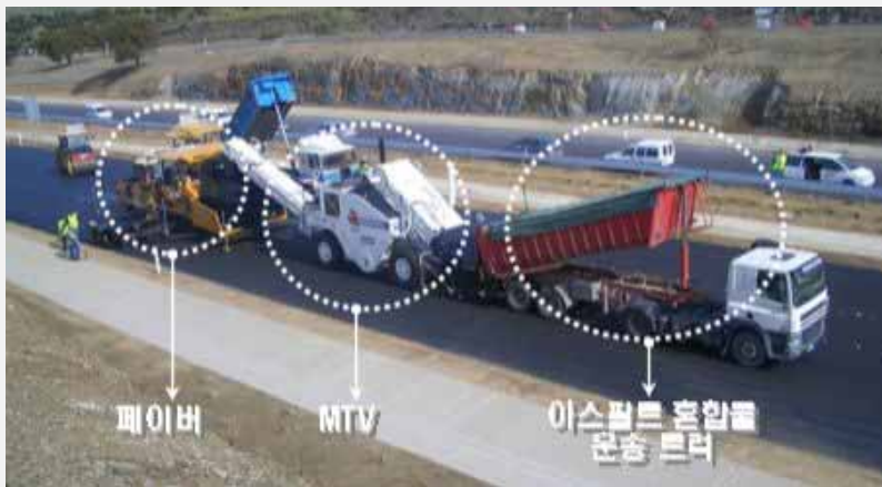
< MTV를 활용한 시공 장면 >
