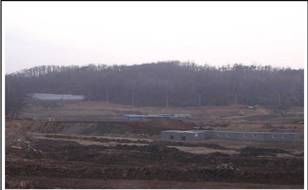
착공 전 현장 전경 사진(1단지)
