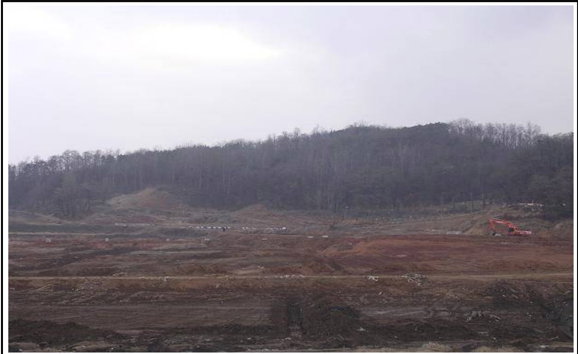
착공 전 현장 전경 사진(4단지)
