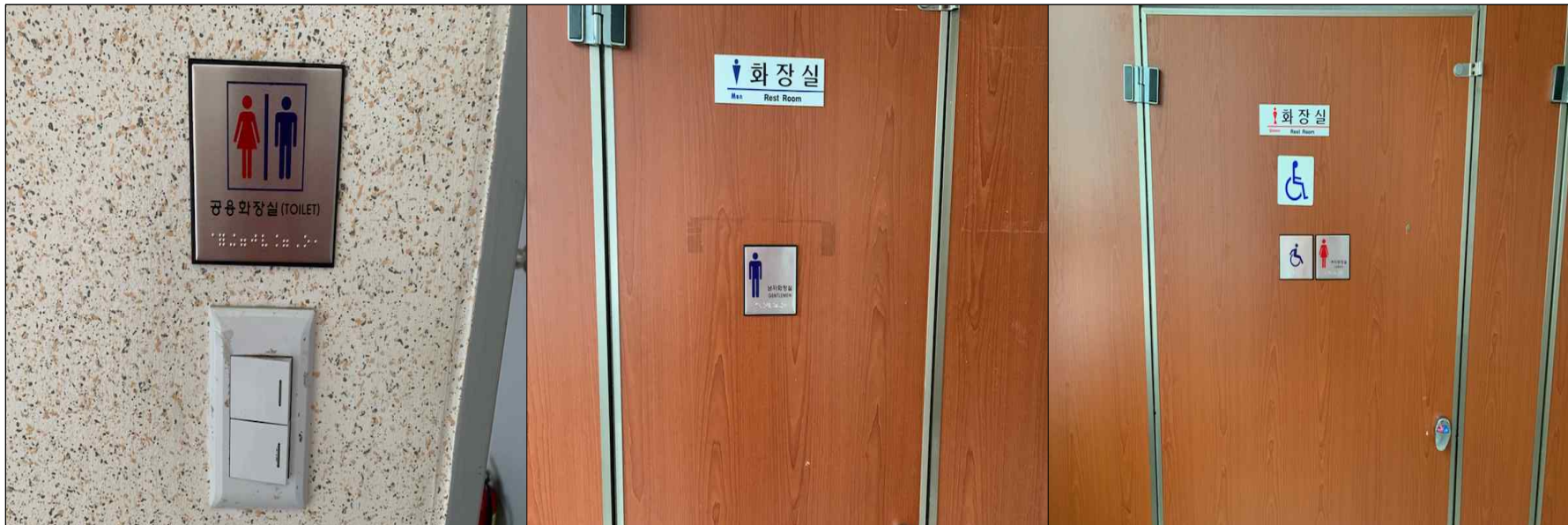
1. 화장실 출입구(문) 벽 1.5m 높이에 점자판 설치 완료
