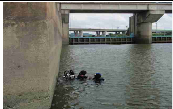
외관조사 사진 ④
