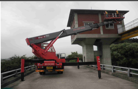
외관조사 사진 ①
