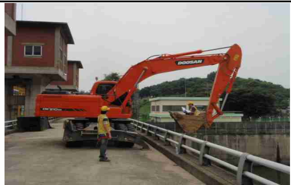
외관조사 사진 ②
