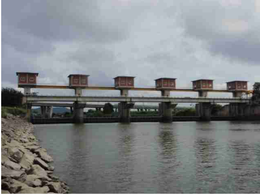
신곡 수중보 전경 (가동보-하류측 방향)
