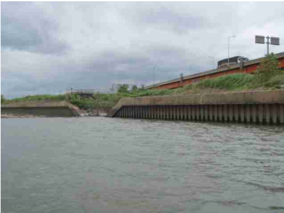
신곡 수중보 전경 (고정보 우안 옹벽)
