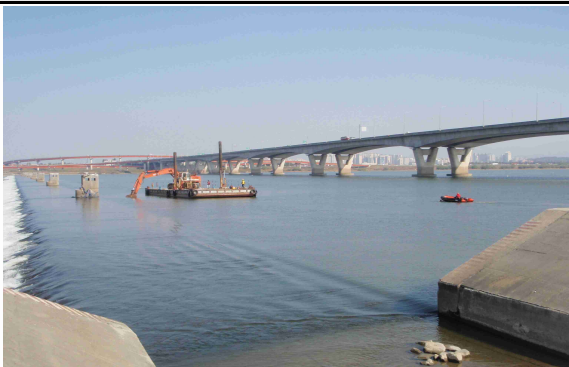
외관조사 사진 ③
