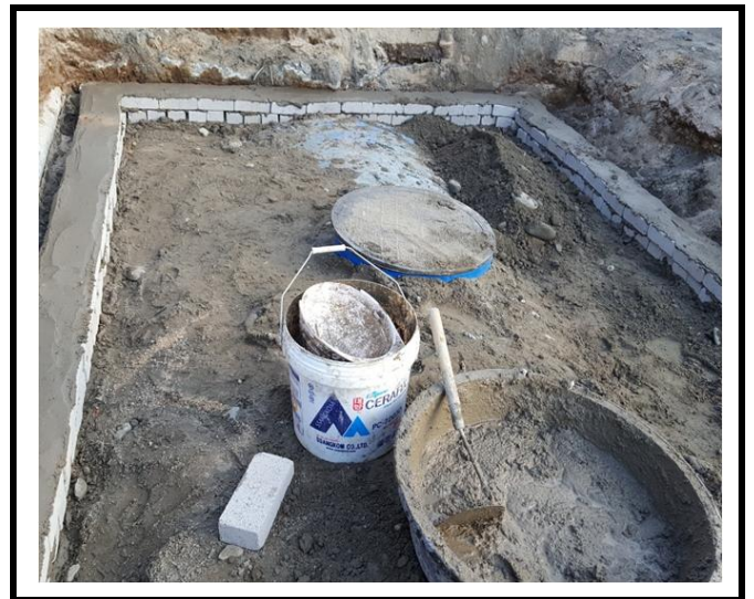
6. 되메우기 및 보호벽 설치
