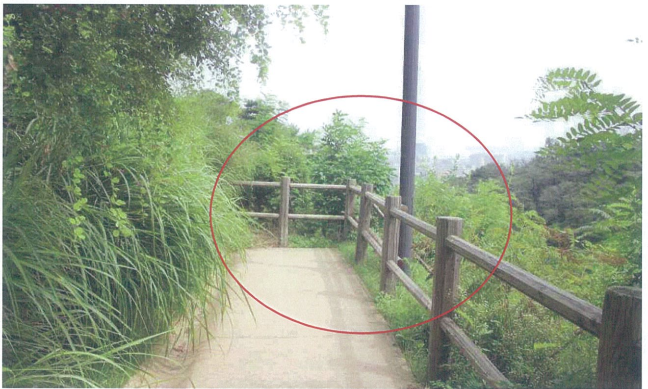
전망데크 설치 현황사진(옥인동 179-5번지)
