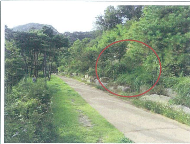
당초 설치 위치(문화재 자문 위치)
