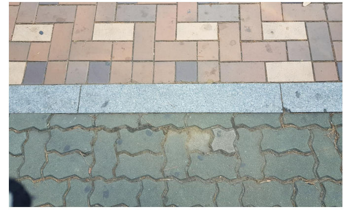
- 보도블록포장 및 경계석 교체
